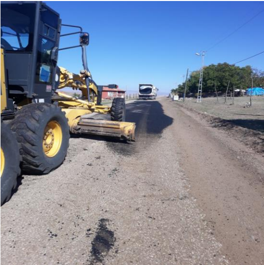
Asfalt Yama Çalışması
