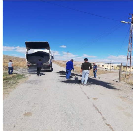
Asfalt Yama Çalışması
