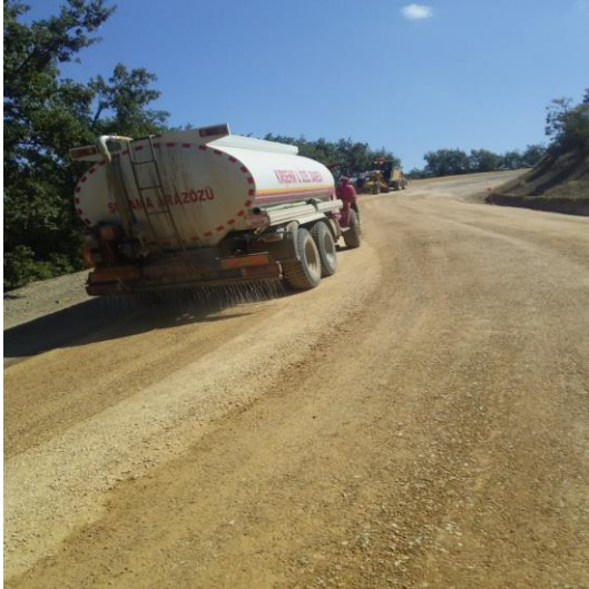
II. Kat Asfalt Kaplama Çalışması
