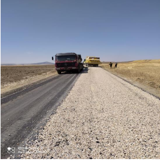
I. Kat Asfalt Kaplama Çalışması
