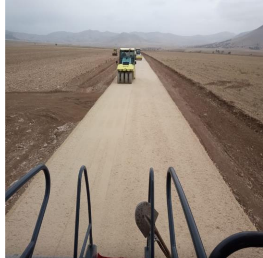
II. Kat Asfalt Kaplama Çalışması
