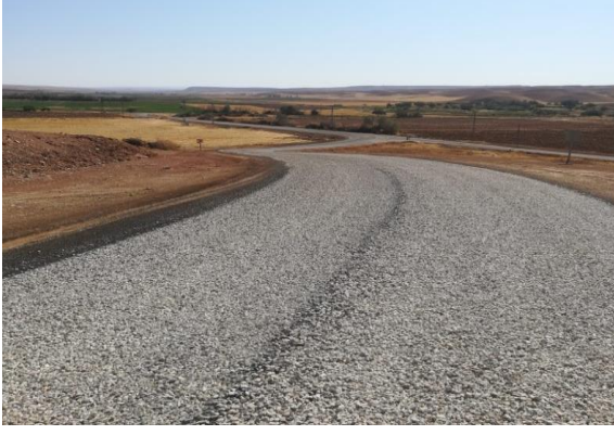
Susuz, Yeniköy I. Kat Asfalt Kaplama
