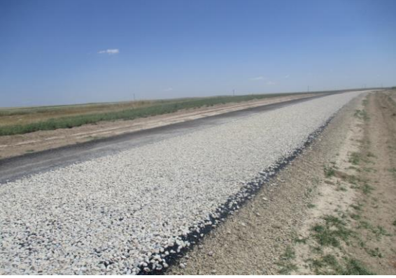
I. ve II. Kat Asfalt Kaplama Çalışması Görüntüleri
