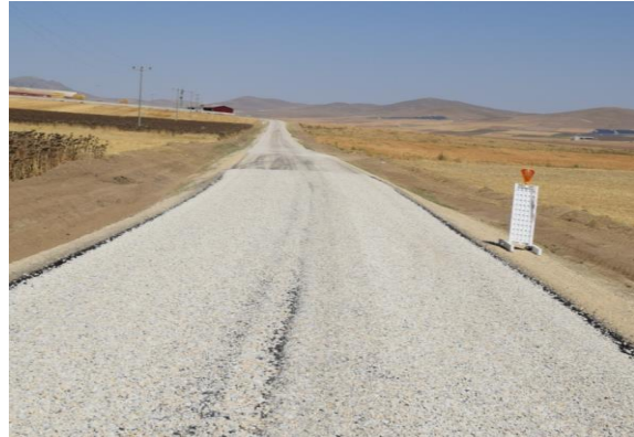
Çimeli, Körpınar I. Kat Asfalt Kaplama
