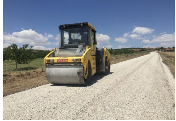
I. ve II. Kat Asfalt Kaplama Çalışması Görüntüleri
