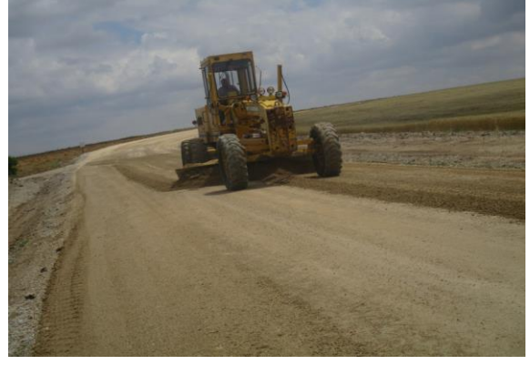
Yol Yapım Çalışması
