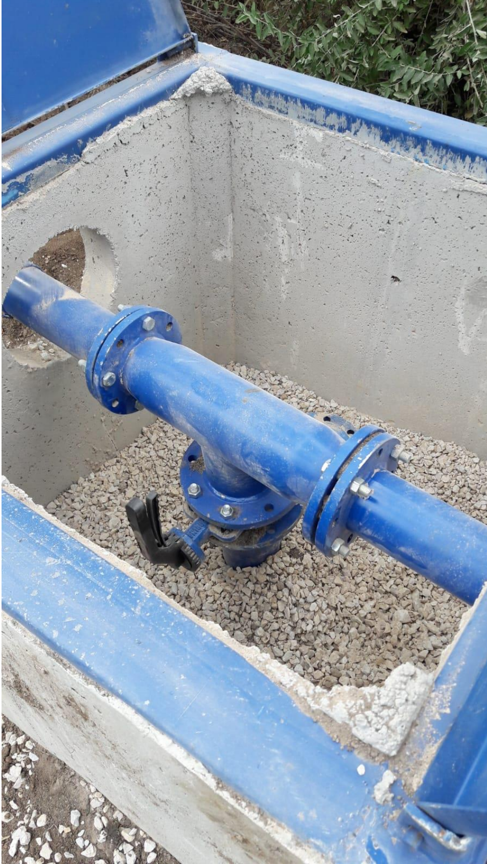
İçme Suyu Çalışmaları
