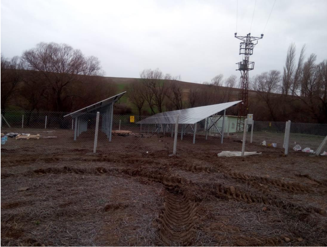
İçme Suyu GES
