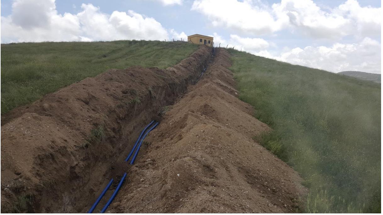
İçme Suyu Çalışmaları
