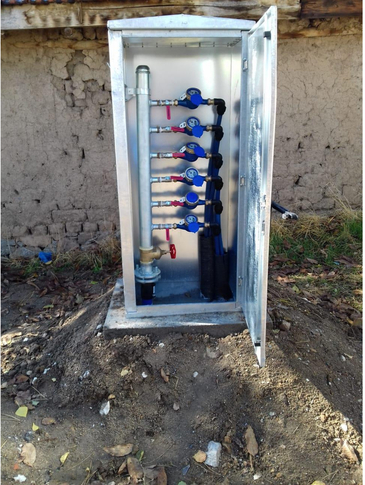
İçme Suyu Çalışmaları
