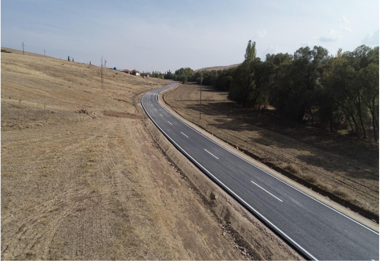
BSK (Bitümlü Sıcak Karışım) Çalışmaları
