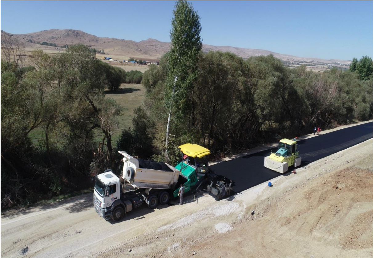
BSK (Bitümlü Sıcak Karışım) Çalışmaları
