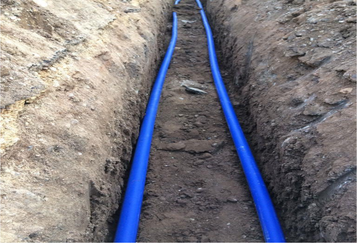
İçme Suyu Çalışmaları
