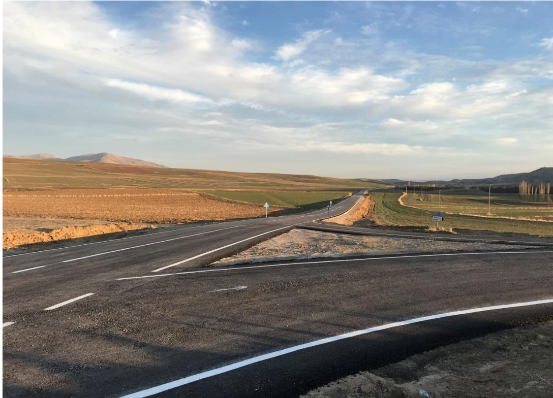
BSK (Bitümlü Sıcak Karışım) Çalışmaları
