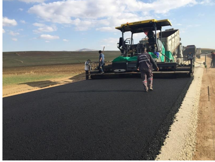
BSK (Bitümlü Sıcak Karışım) Çalışmaları
