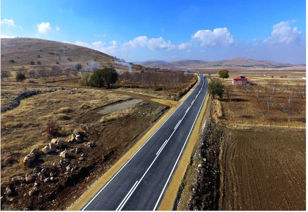
BSK (Bitümlü Sıcak Karışım) Çalışmaları
