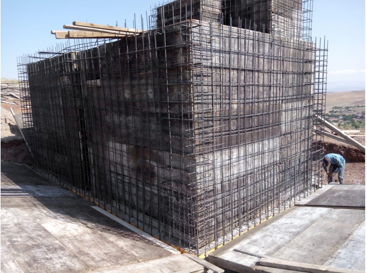
İçme Suyu Çalışmaları
