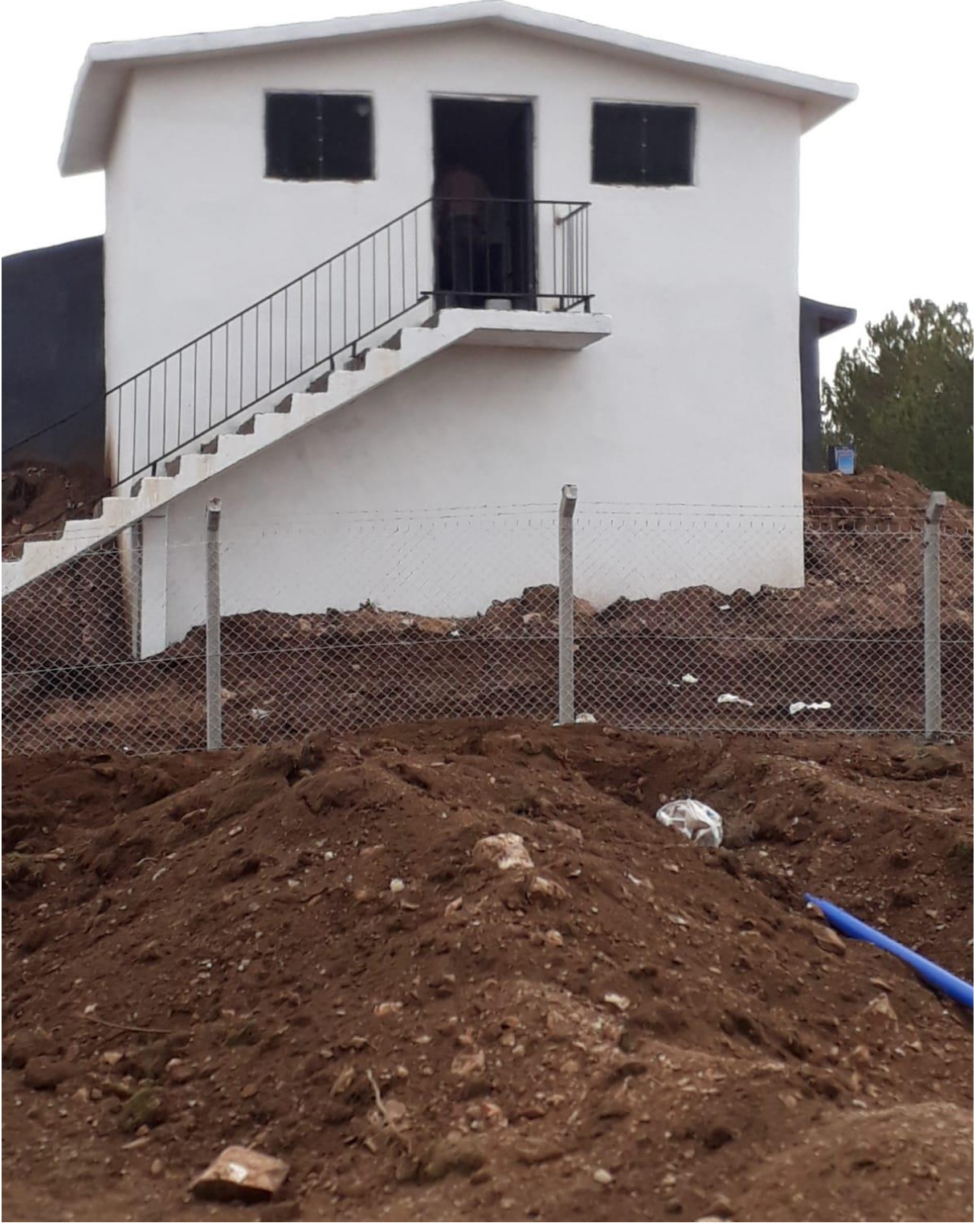
İçme Suyu Çalışmaları
