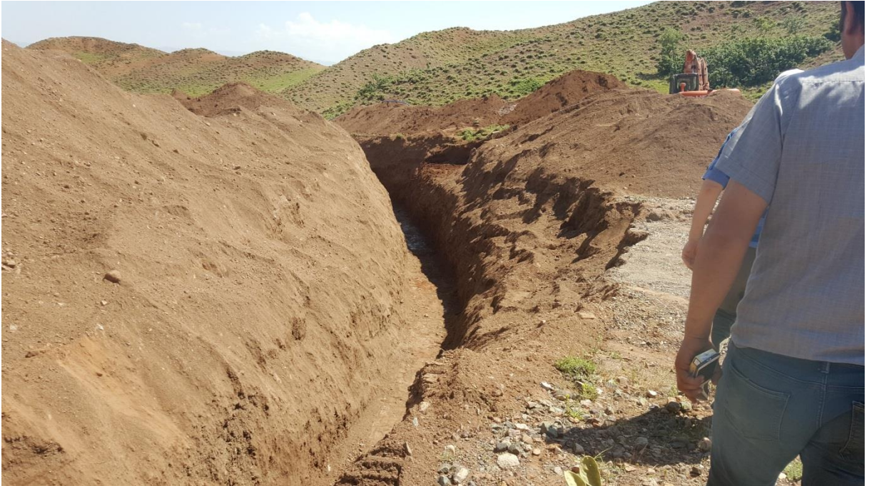
İçme Suyu Çalışmaları
