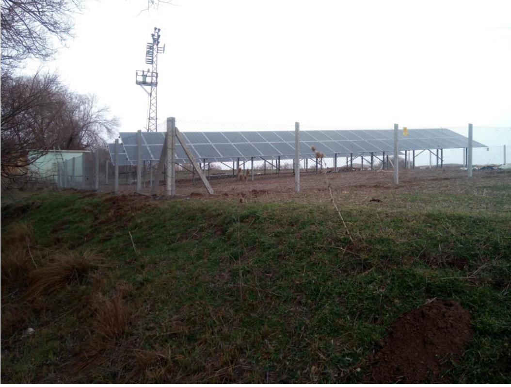
İçme Suyu GES
