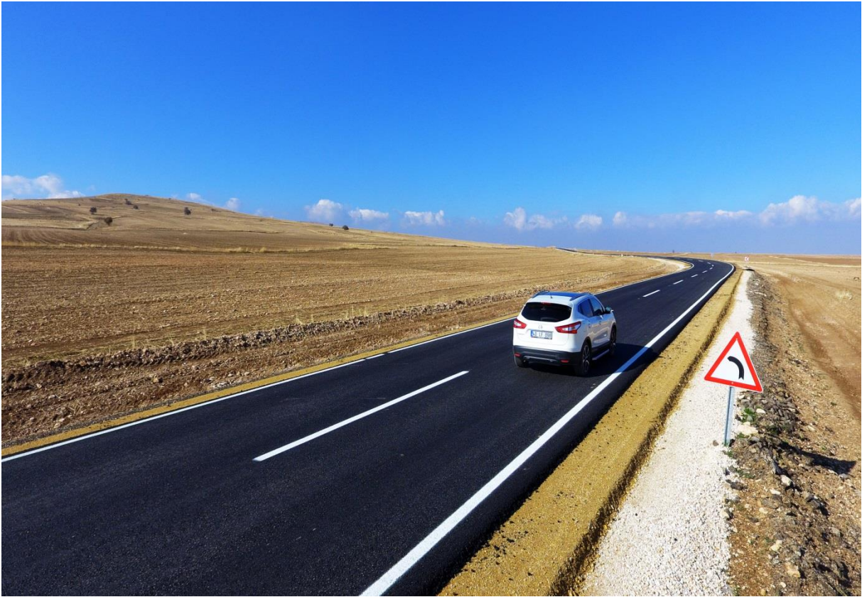
BSK (Bitümlü Sıcak Karışım) Çalışmaları
