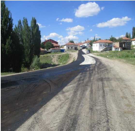
1. Kat, 2. Kat Asfalt Sathi Kaplama ile Yama Çalışmaları
