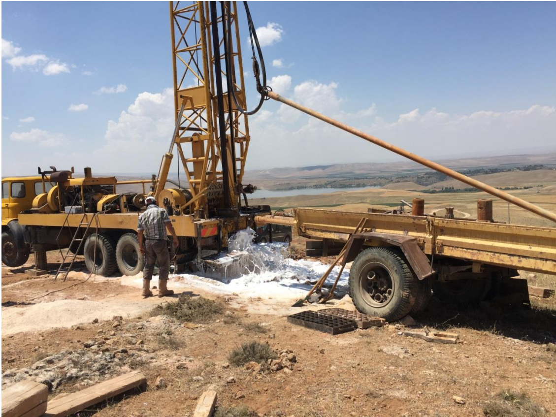
İçme Suyu Sondaj Çalışmaları
