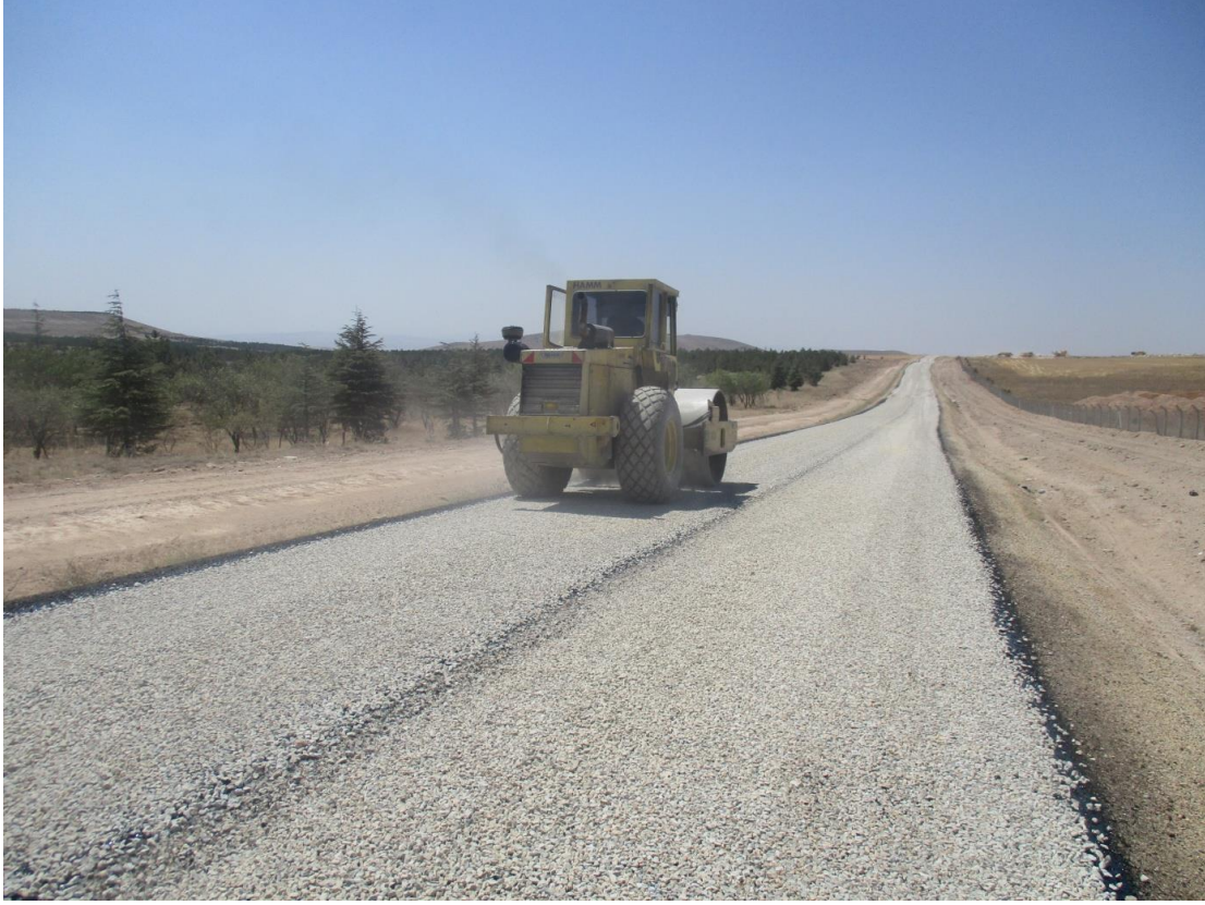
Köy yolları ve köy içi sathi kaplama çalışmaları
