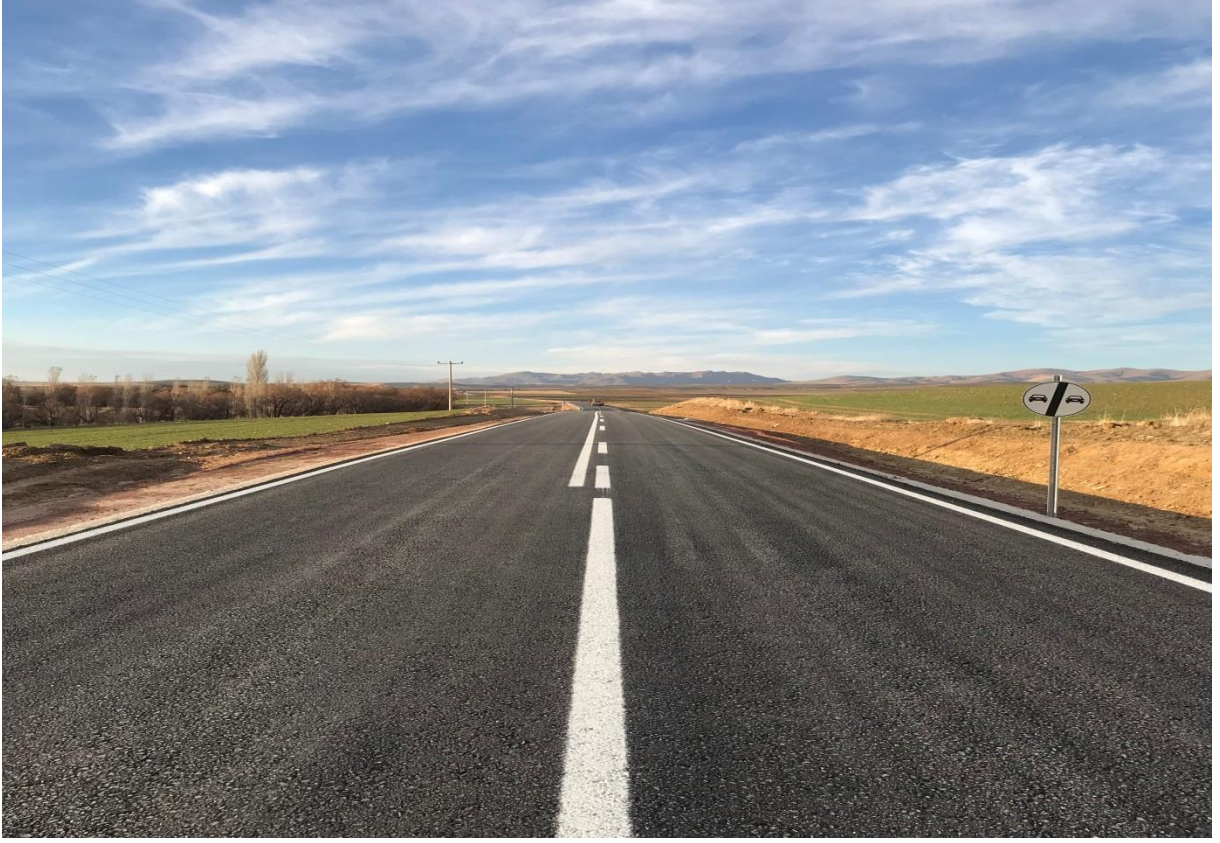
BSK (Bitümlü Sıcak Karışım) Çalışmaları
