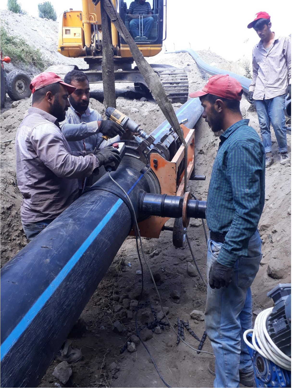
İçme Suyu Çalışmaları
