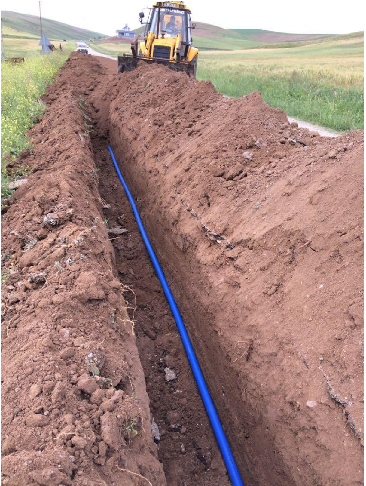
İçme Suyu Çalışmaları
