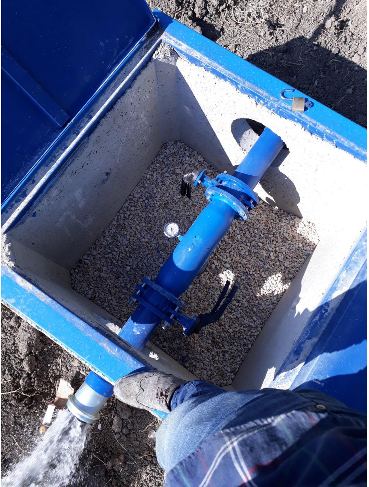
İçme Suyu Çalışmaları
