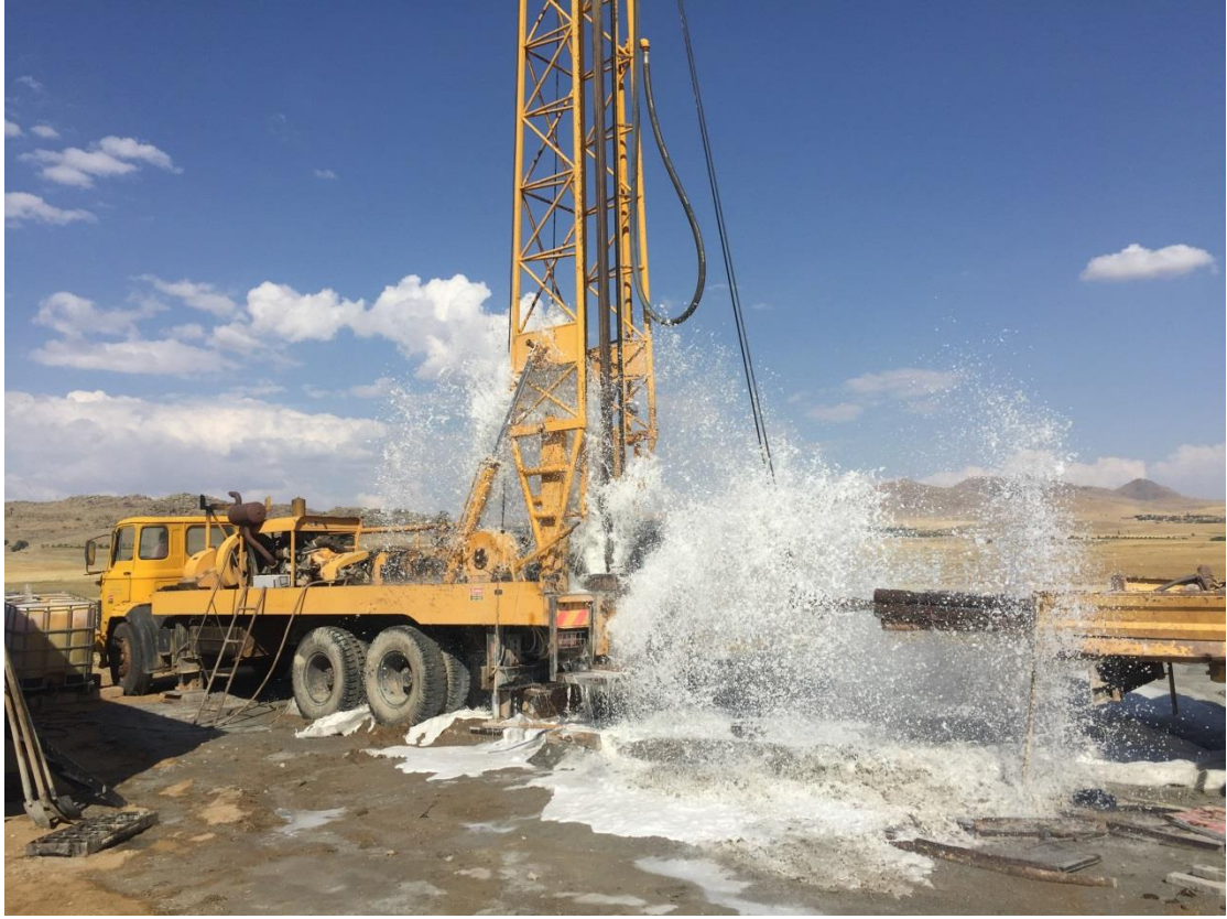
İçme Suyu Sondaj Çalışmaları
